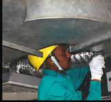
HAVALANDIRMA KANALI MONTAJI
